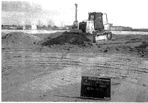
成工新店はICT建機を活用して佐賀空港駐車場を整備した
