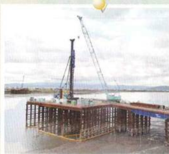
大きな川に橋を架ける 工事をやっているよ!
